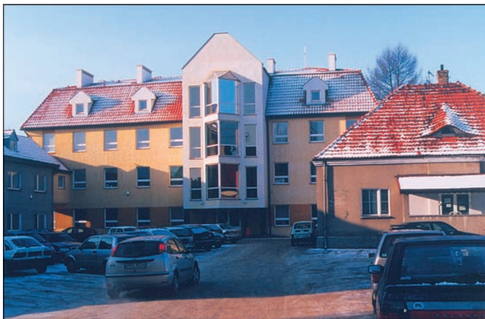
Nowy budynek Starostwa przy ul. Poznańskiej 79.
