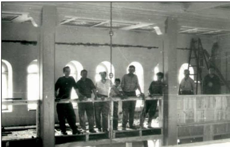
Rok 1967. Prace remontowe na balkonach kościoła.
